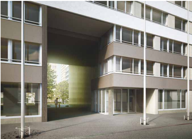
Der Blick in einen der zwei Durchgänge in den Maaghof.
